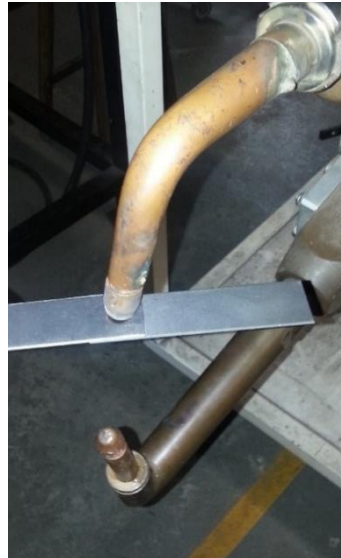
Figura 29 - Posicionamento das chapas para a execução da soldagem
