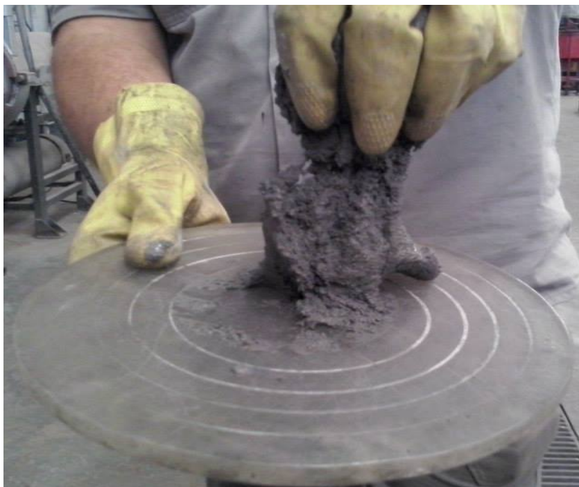
Figura 11 Aspecto viscoso de concreto com geopolímero
