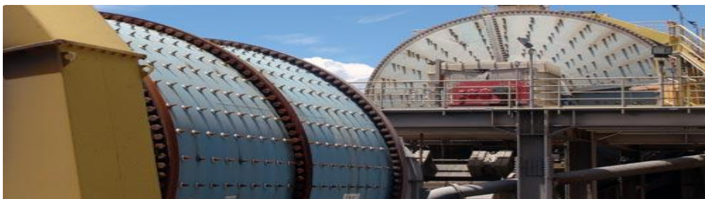
Figura 6 - Equipamento de moagem – moinho de bolas.
