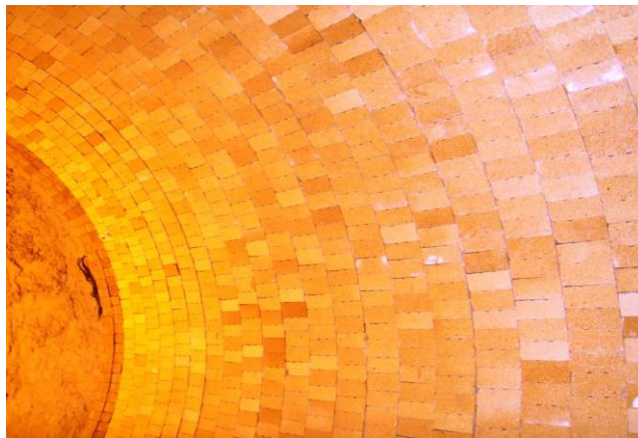
Figura 1 - Exemplo de montagem de Material Refratário para alto-forno
