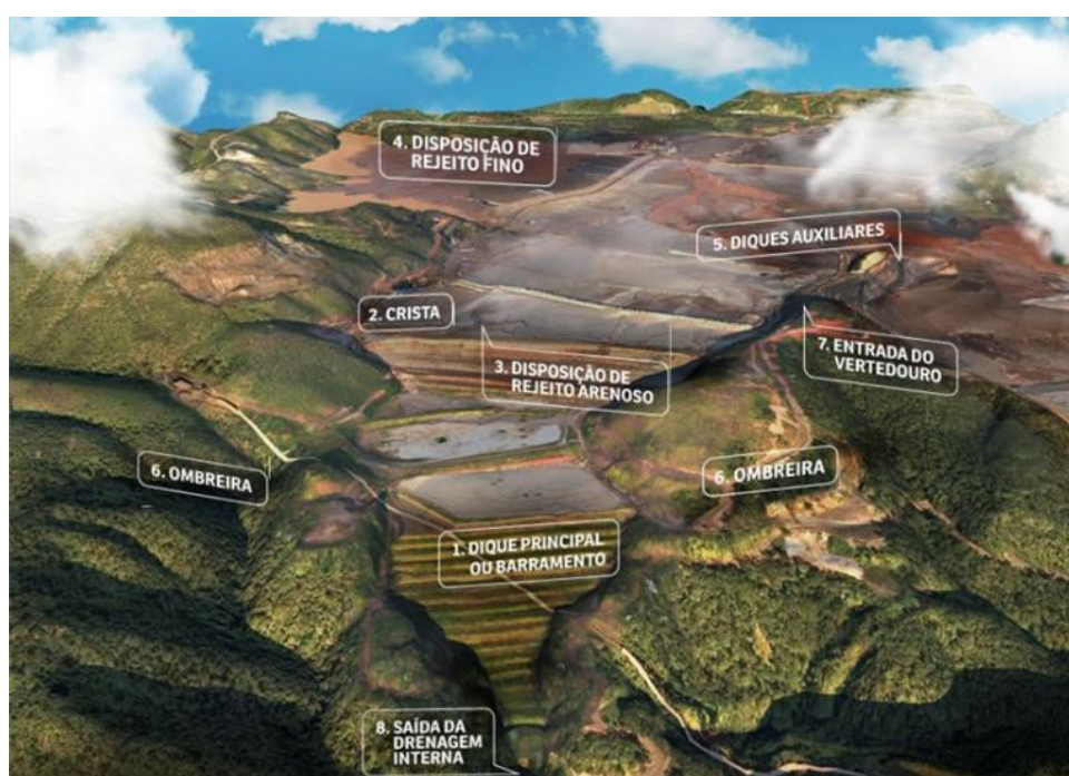
Figura 7 – Estrutura da Barragem.
