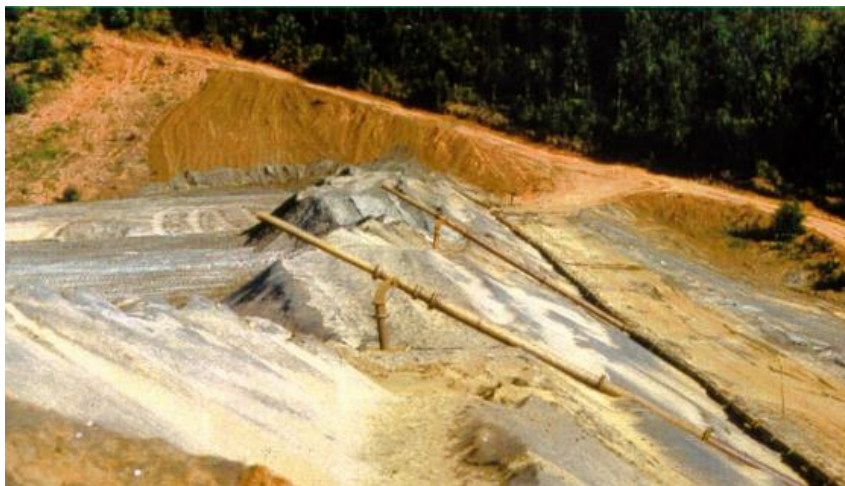
Figura 3 - Disposição de resíduos granulares através de tubulações
