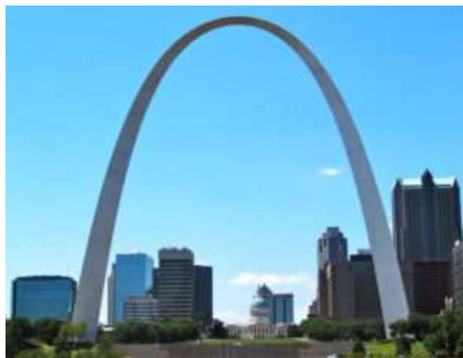
Figura 1 – Arco de Saint Louis com revestimento de aço inoxidável AISI 304.
