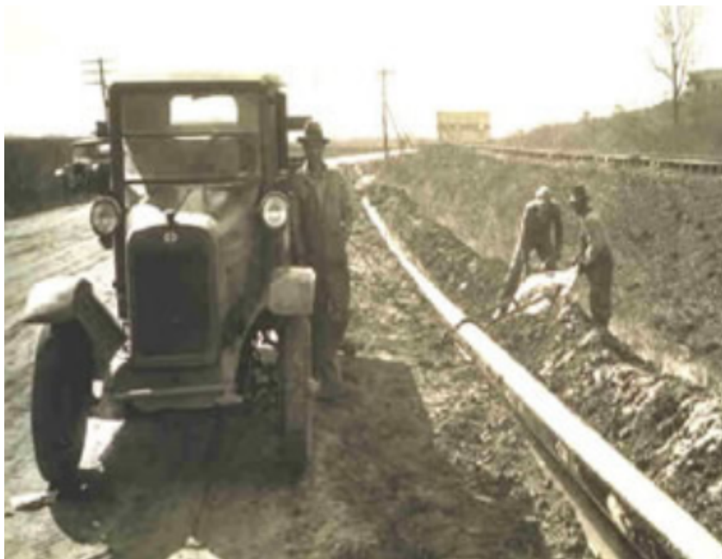
Figura 1 - Imagem de uma infraestrutura antiga de dutos
