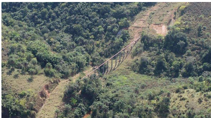
Figura 3.2 – Visão aérea do km 41 do mineroduto no trecho Minas-Rio da Anglo American
