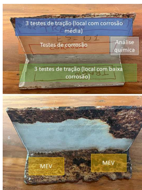
Figura 5.1 – Amostras retiradas da viga de sustentação do espessador de polpas e os ensaios associados a cada região
