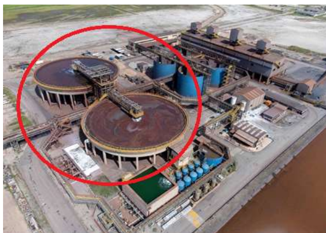
Figura 3.4 – Espessador da Anglo American
